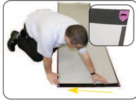
Aplicar el hanger en el borde superior interno del panel asegurándose de que está en el borde del panel
